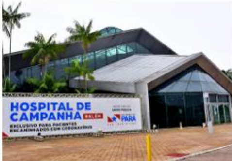
Hospital de Campanha Hangar – Belém
