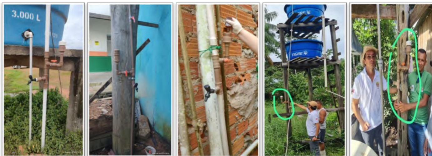
Figura 4: Instalação de Cloradores artesanais em cinco municípios.
