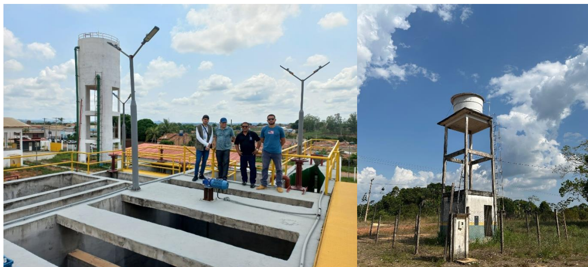
Figura 5 – Inspeção higiênico-sanitária em formas de abastecimento de água no Pará
